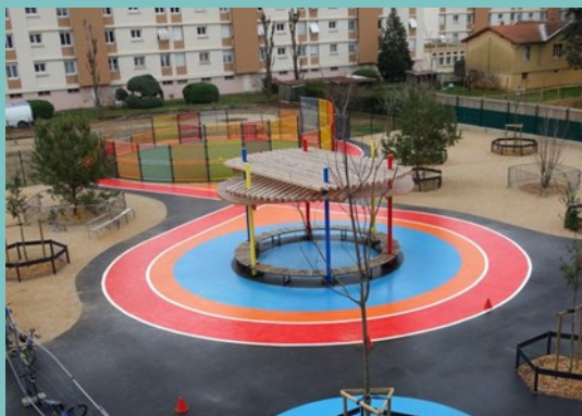
Aménagement de la cour de l'école Vivarais à Guilherand-Granges Source : www.archiclasse.fr
